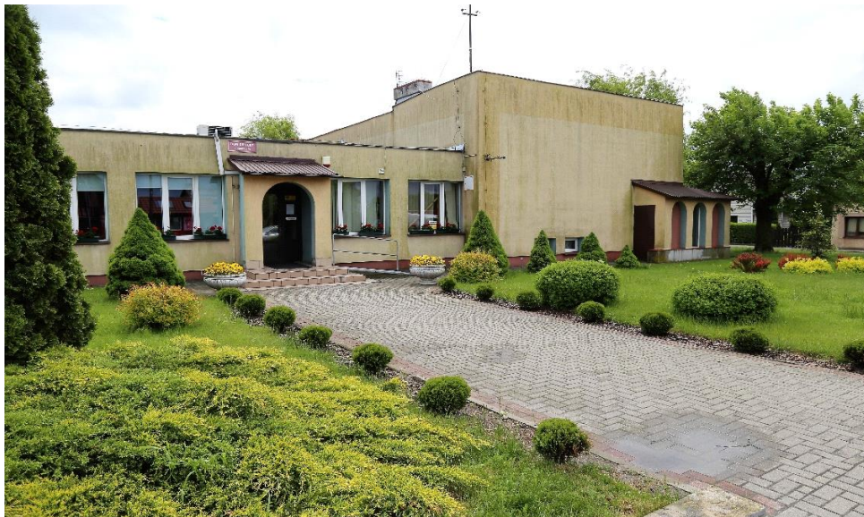
Budynek Domu Kultury, (widok przed rozpoczęciem rozbudowy)
