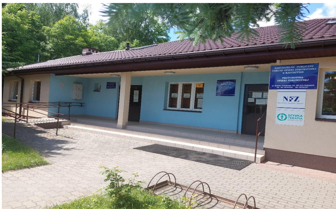
Budynek przychodni Zdrowia przy ul. Wojska Polskiego
